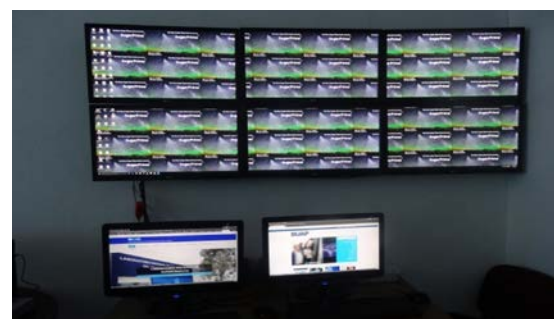
Figura 2. En la figura se muestra el estado actual de las Salas de Monitoreo Remoto de la Colaboración Auger, las primeras 4 ya se encuentran funcionando y las restantes están en proceso de instalación
