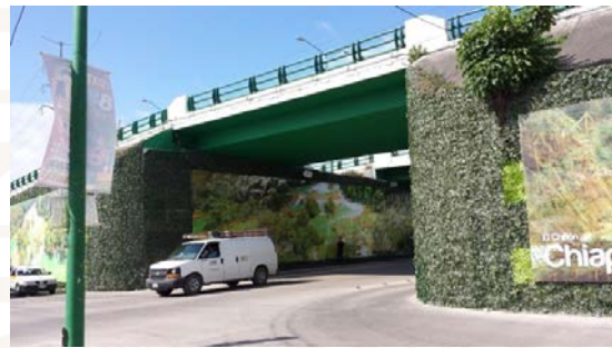
Figura 4. Paso desnivel 3. Calle central (16° 77' 34.47" N 93° 12' 04.38" O)
