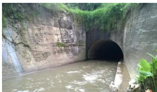
Figura 2. Vista de la entrada del Túnel
