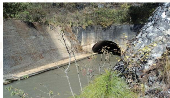
Figura 3. Vista de la salida del Túnel
