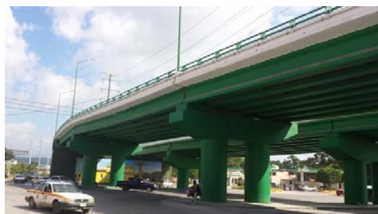
Figura 3. Paso desnivel 2. Calzada al sumidero (16° 77' 06.21" N – 93° 11' 27.04" O)
