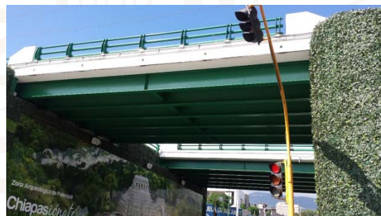
Figura 5. Paso desnivel 4. Calle 5a Poniente, Col. Albania. (16° 77' 43.04" N – 93° 12' 32.35" O)
